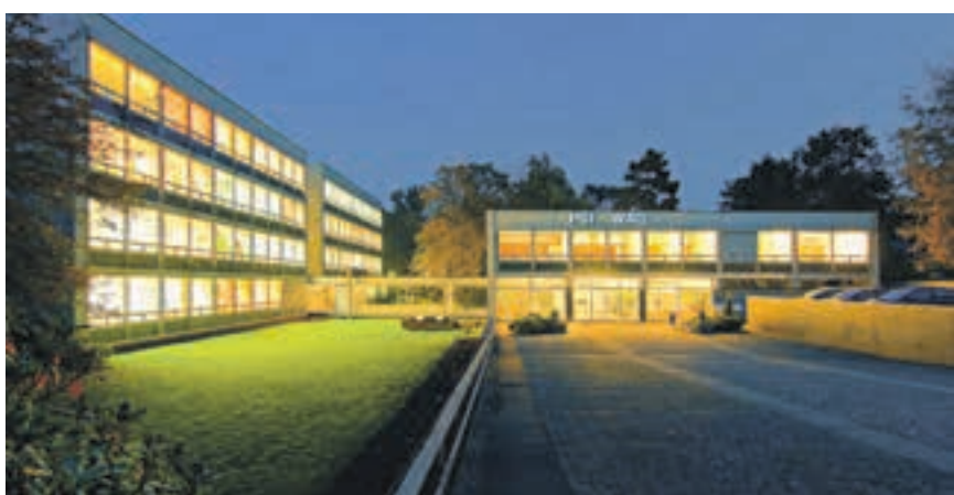
Gebündelte Kompetenz unter einem Dach: die WAG-Firmenzentrale.
